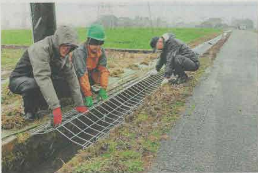
通学路沿いの農業用水路に転落防止カバーを設置する東野尻地区委員会メンバー ＝砺波市野村島
